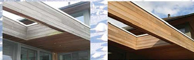
ceder gevelbekleding voor en na reiniging met NANODRY Wood Cleaner
